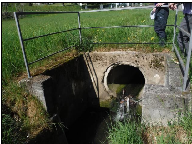
Figure 18 e 19 – Roggia Valletto all'uscita della tombinatura di via Rocchina
